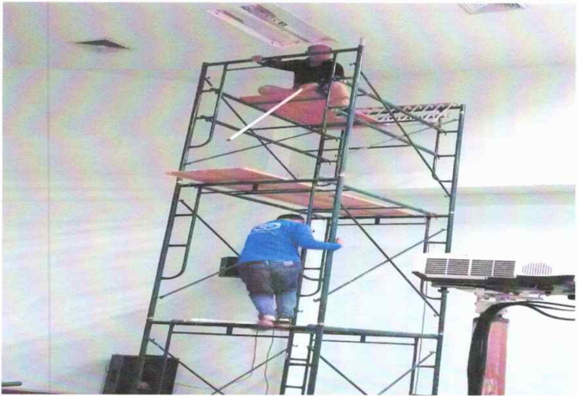
ตรวจสอบและเปลี่ยนหลอดไฟฟ้าแสงสว่าง
