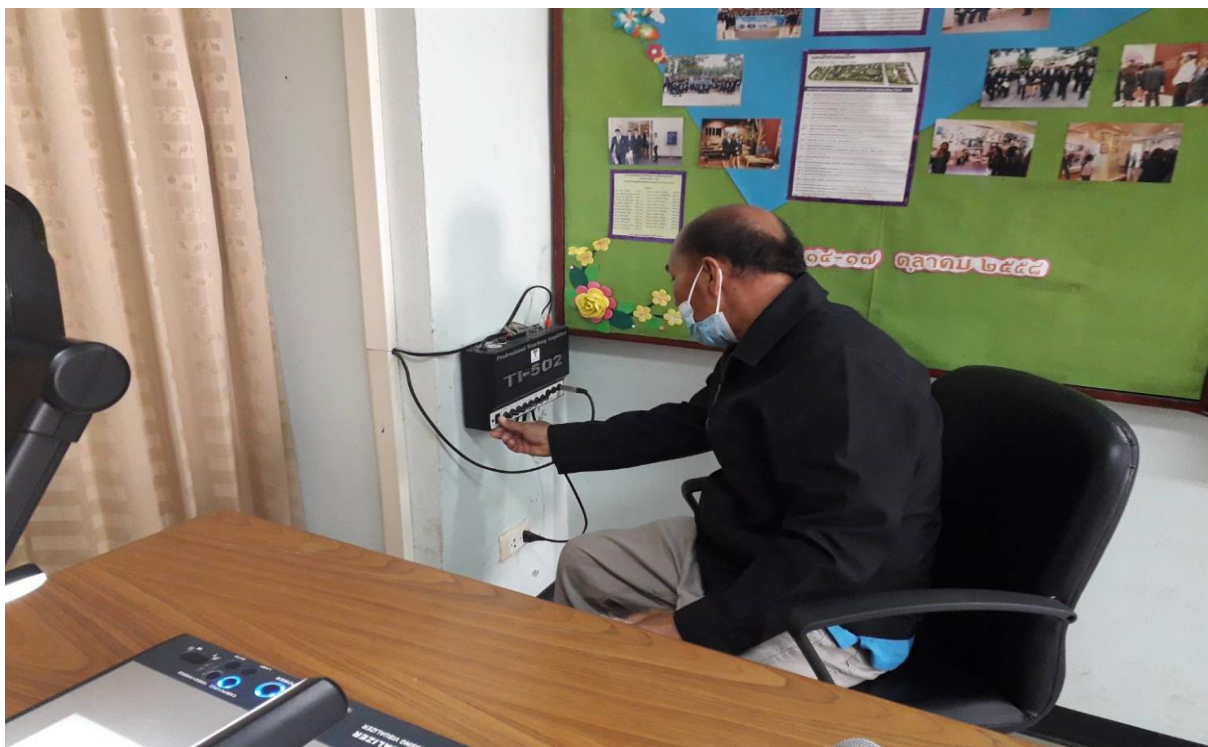
ตรวจสอบและทำความสะอาดเครื่องขยายเสียงและไมโครโฟน ภาคเรียนละ 1 ครั้ง
