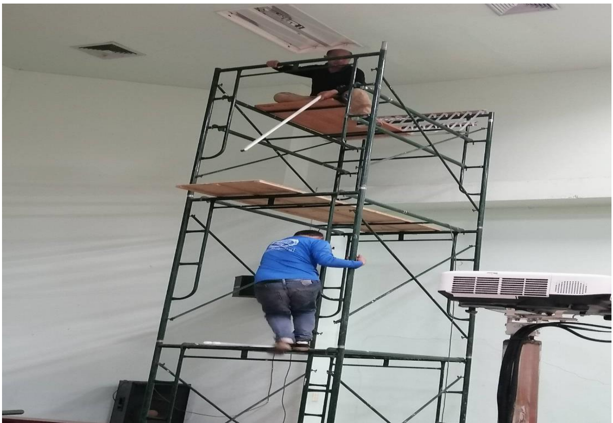
ตรวจสอบและเปลี่ยนหลอดไฟฟ้าแสงสว่าง
