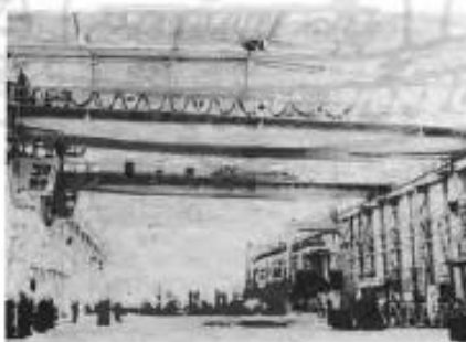
รูปที่ 8 - 11 ไอเวอร์เฮด เครน (Overhead Crane)
